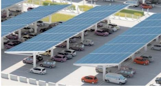
Illustration 14. ombrières équipées de panneaux solaires photovoltaïques
